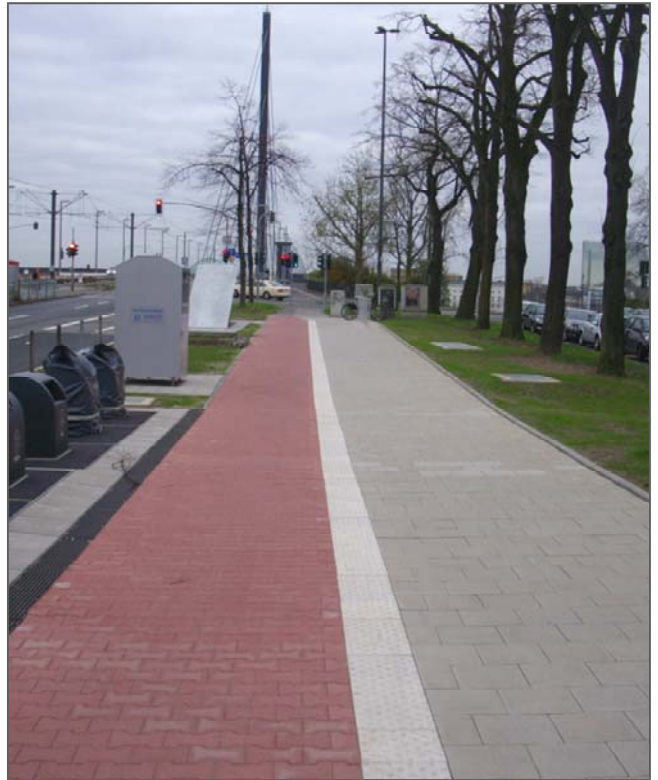
Bild 5-13: Getrennter Fuß- und Radweg
