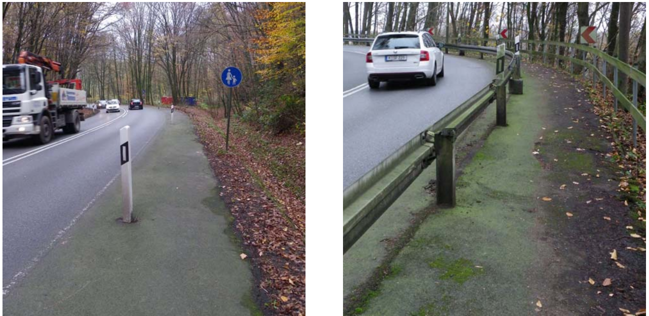
Bild 5-9: Bestand Ittertalstraße, Gehweg auf Seitenstreifen und hinter der Leitplanke
