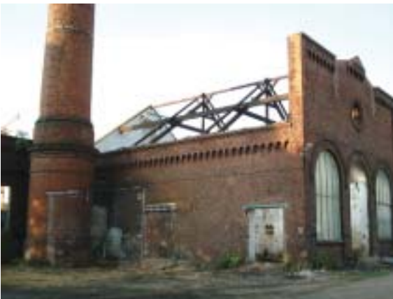
Ruine der Weberei Besenbruch
